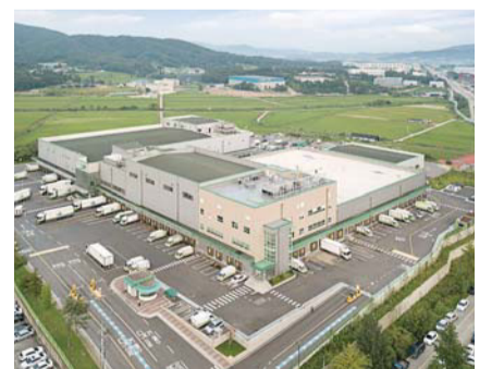
풀무원 푸드머스 양지물류센터. /풀무원
