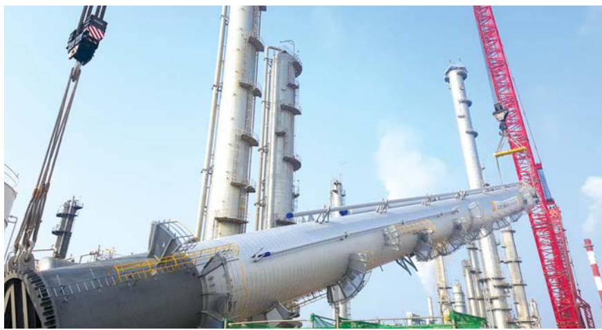
대산공장 증설에 나선 한화토탈이 99m에 달하는 프로필렌 정제설비를 기립시켰다. /한화토탈
