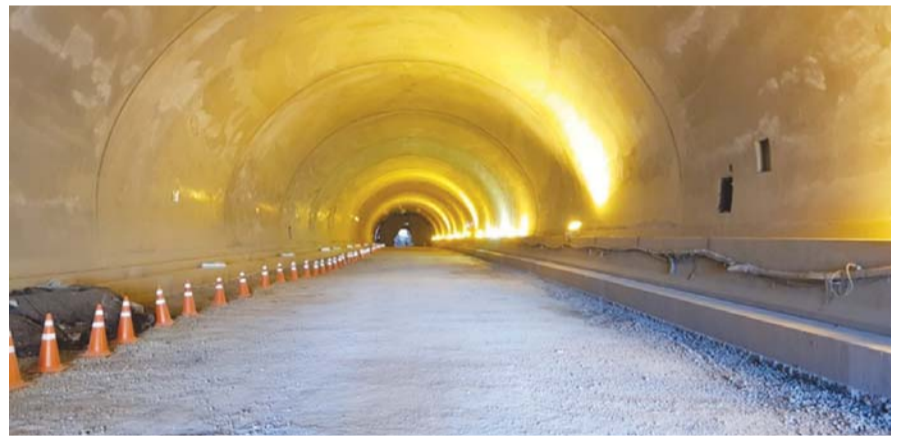
서초역~내방역 구간 연결 터널. /서울시
