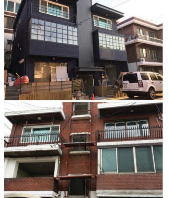
에이원리얼트루가 진행한 노후 주택 리노베이션. 리모델링 전(아래)과 리모델링 이후.
