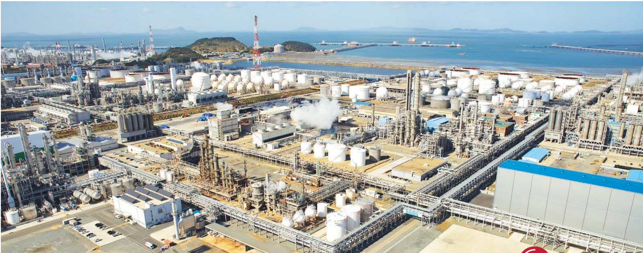
충남 서산시 대산읍에 위치한 155만㎡(47만평) 규모의 LG화학 대산공장 전경. LG화학은 엘라스토머, NCC 등의 설비 증설을 통해 '글로벌 3위'의 화학업체로 도약을 준비하고 있다.
