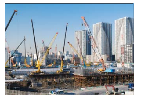
공사 현장 이미지. /픽스타
