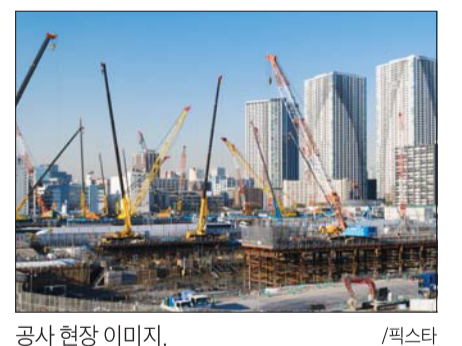
공사 현장 이미지. /픽스타
