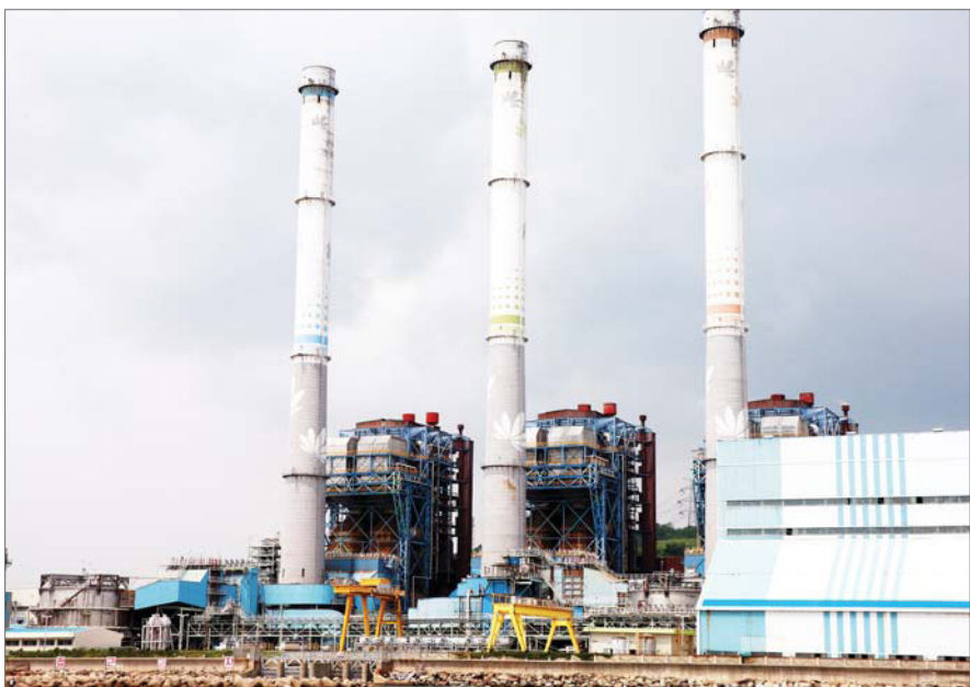
동서발전 소속 울산 LNG복합화력 발전소. /뉴스
