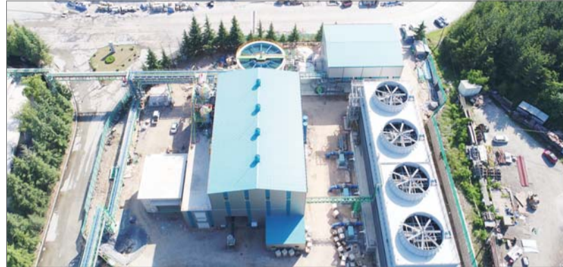
쌍용양회 동해공장에 들어선 폐열발전설비.
