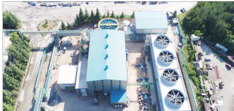
쌍용양회 동해공장에 들어선 폐열발전설비.
