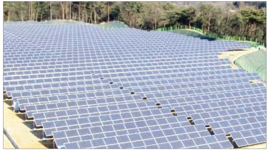
임야에 설치된 태양광 발전 시설.
