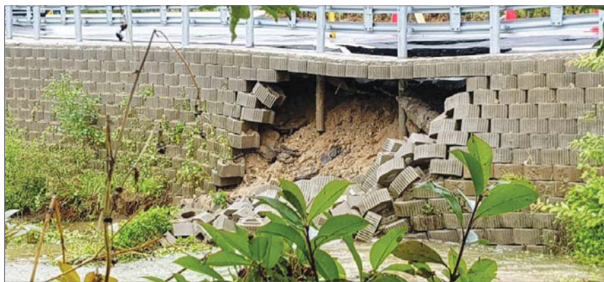
광주 북구 장등동 장등천 장등1교 옆 옹벽이 지난달 28일 내린 장맛비로 높이 3m, 폭 2.5m 정도 무너져 내렸다. 광주시는 무너져내린 옹벽에 모래 가마니를 쌓아 물이 들어가지 못하도록 응급조치를 했다. /연합뉴스
