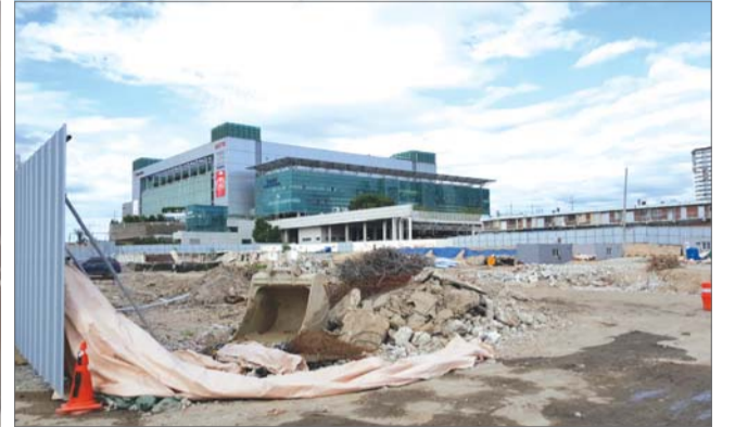
서울 청량리역 앞 청량리4구역(동대문구 청량리 전농동 일대) 공사 현장.
