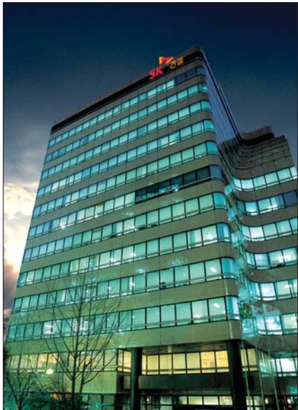
SK건설 빌딩. /SK건설
