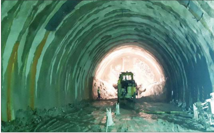
서부간선지하도로 공사 모습.
