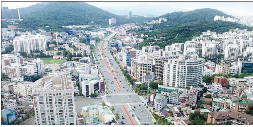
한남2고가 철거 및 중앙버스전용차로 설치공사 조감도. /서울시
