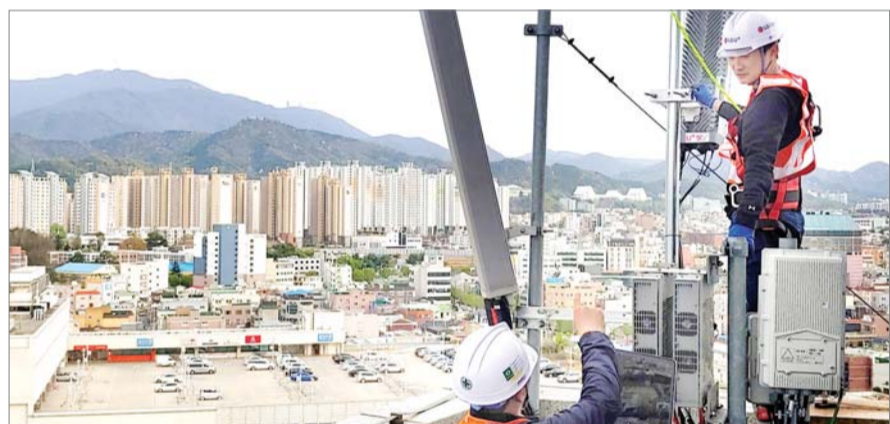
LG유플러스 직원들이 광주광역시 북구 중흥동에 5G 기지국을 구축하고 서비스 품질을 높이기 위한 최적화 작업을 하고 있다. /LG유플러스
