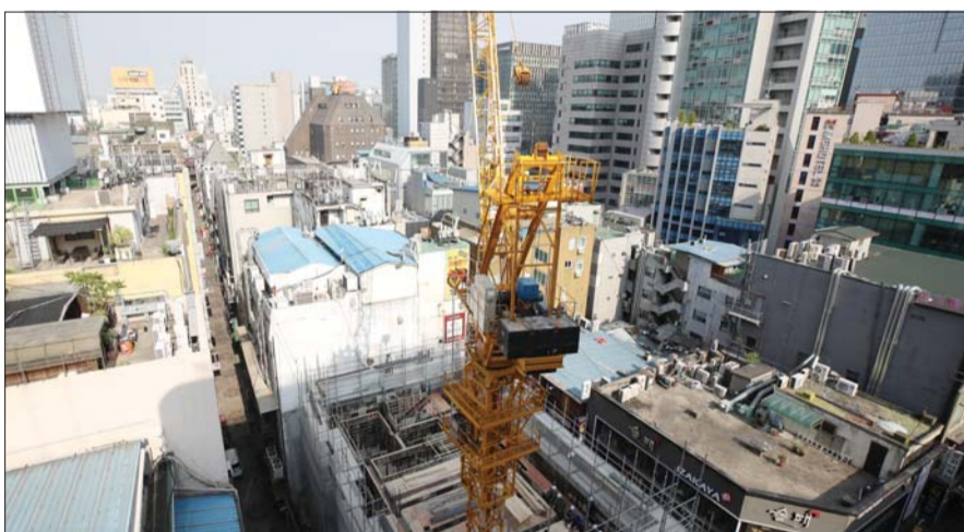
양대 노총 소속 전국 타워크레인 노동자들이 임금 인상과 소형 타워크레인 사용 금지를 요구하며 파업에 돌입하면서 신축중인 고층 건물과 대규모 아파트 공사가 멈춰 섰다. 사진은 4일 오후 서울 시내 한 공사현장의 소형 타워크레인. /연합뉴스
