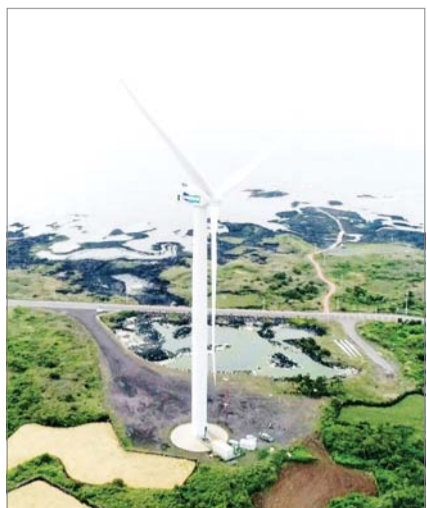
제주 김녕실증단지에 설치된 두산중공업 5.5MW급 해상풍력시스템 전경.
