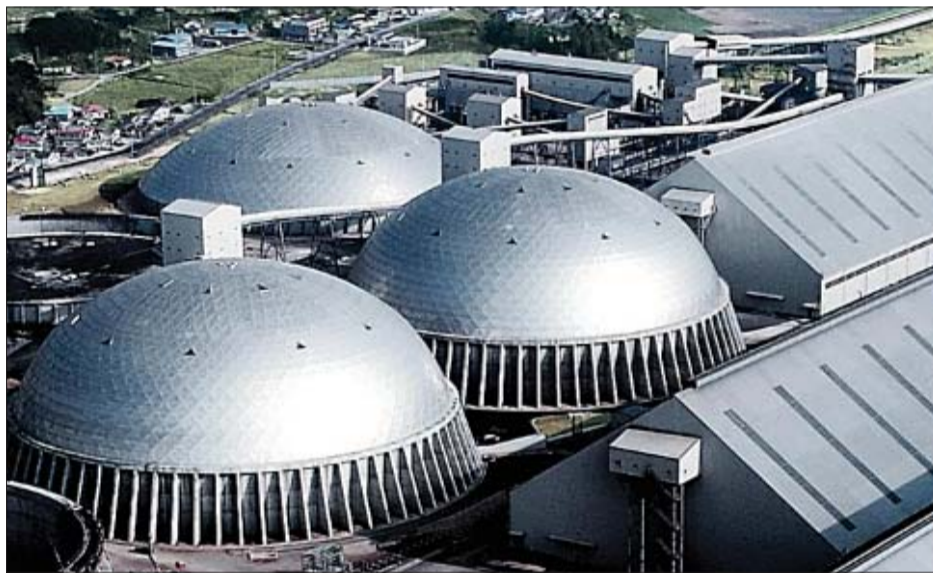
현대제철소 당진공장 전경(위), 당진공장의 돔형 원료저장시설 전경.
