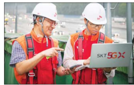
경기 성남시서울 톨게이트 인근 건물 옥상에서 SK텔레콤 직원들이 기지국 점검을 하고 있다. /SK텔레콤
