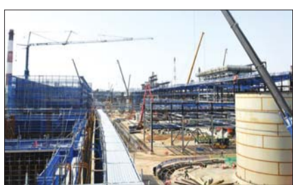
지난 3월 SK에너지 울산CLX 내 감압 전사유 탈황설비 공사 현장.
