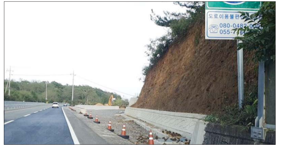
사천시 곤명면 국도2호선 도로에 접해있는 휴게소 신축현장
