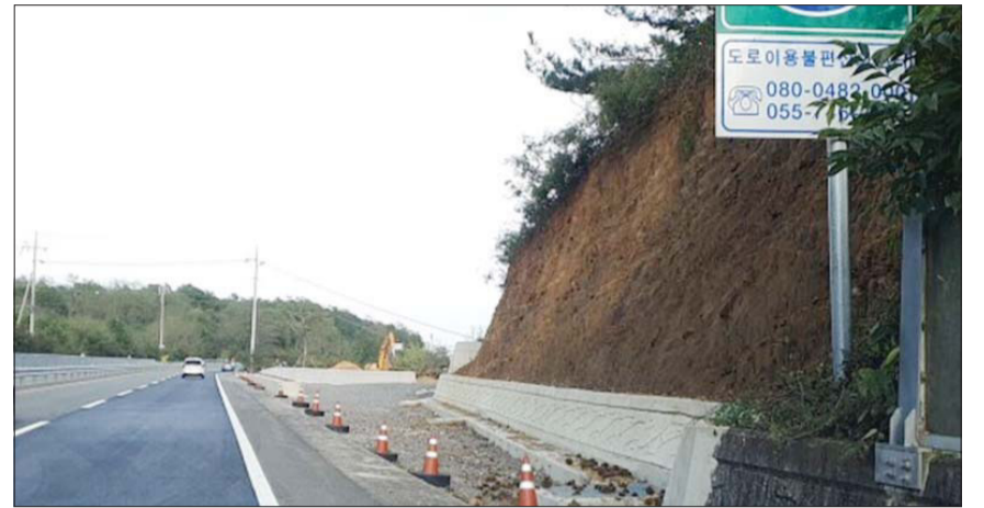
사천시 곤명면 국도2호선 도로에 접해있는 휴게소 신축현장
