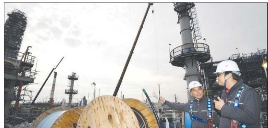
SK에너지가 IMO2020에 따른 저유황 수요에 대비하기 위해 약 1조원을 투자해 건설 중인 VRD S(감압잔사유탈황설비) 공사 현장. /뉴시스
