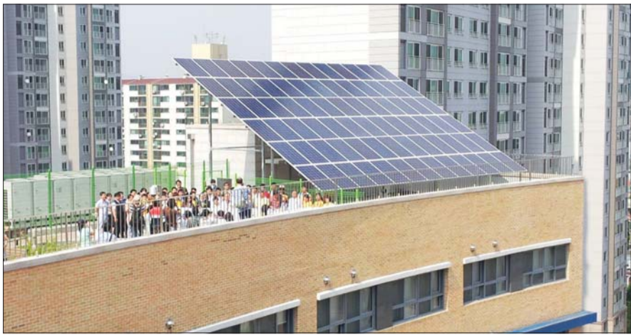
강북구 미아동 삼각산 고등학교에 설치된 소형 태양광 발전소. /서울시
