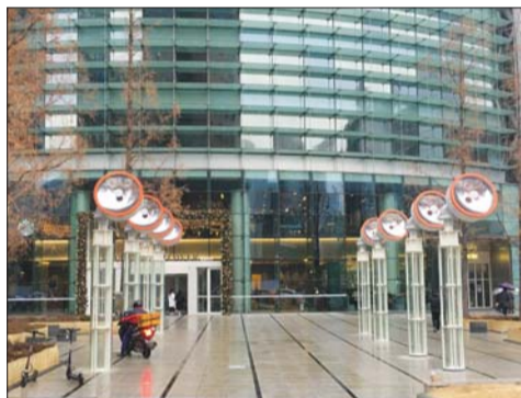
종각역 지상에 설치된 8개의 집광부 장치. /사진=김현정 기자
