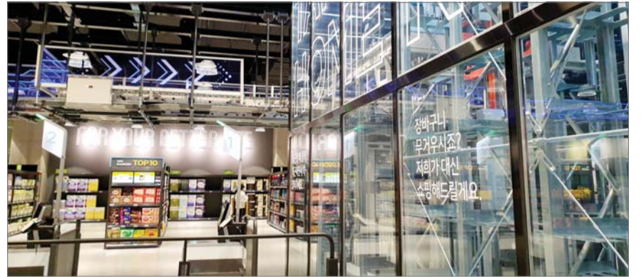
'픽셀' 서비스를 제공하는 물류 자동화 설비 시스템이 자리잡은 이마트 청계천점 지하 1층의 매장 위로 제품이 배달되는 컨베이어벨트가 보인다. SSG닷컴 인기 상품을 파는 지하 1층 코너는 무인계산대로만 운영된다.
