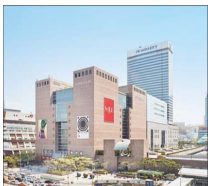
신세계백화점 강남점 /신세계백화점
