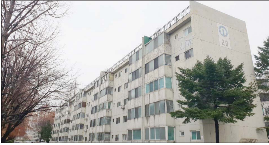
반포 주공1단지 3주구 재건축 사업을 두고 삼성물산과 대우건설 간의 수주 경쟁전이 치열하다. 반포3주구 아파트 전경. /정연우 기자
