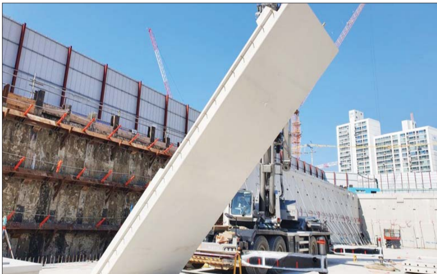
서울 중산2구역 재개발 현장에서 지하주차장 외부 벽체를 국내 최초로 프리캐스트 콘크리트 시공중인 모습. /GS건설
