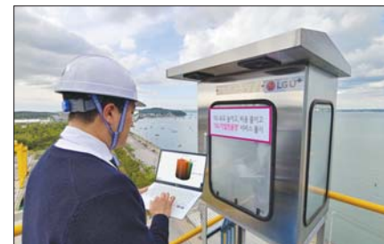
LG유플러스 관계자가 충남 당진에 위치한 GS EPS 공장에서 5G 기업전용망 서비스를 통한 레벨센서 합체를 점검하고 있다. /LG유플러스
