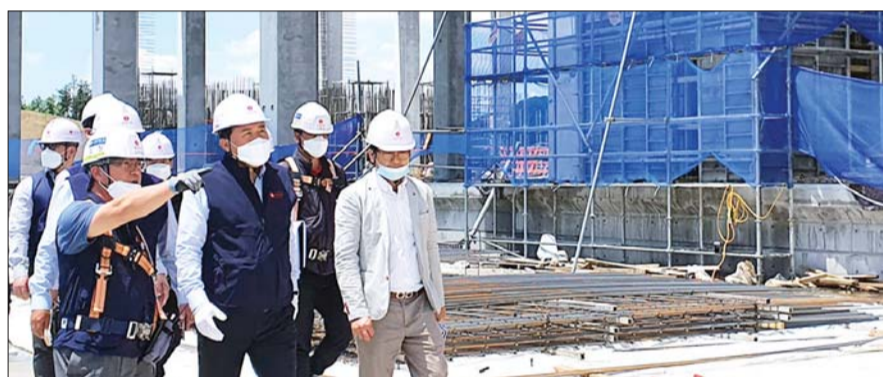
롯데지주 황각규 부회장이 20일, 충북 진천의 롯데글로벌로지스 택배 메가 허브(Mega Hub) 터미널 건립 현장을 방문했다. /롯데지주
