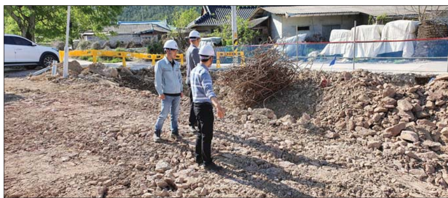
화순군 재난대비 공사현장 점검
