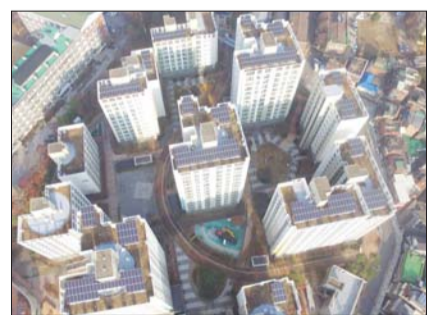
한화큐셀의 태양광 대역사업으로 한화큐셀 큐피크 모듈을 설치한 서울 중랑구 망우동 소재 중앙숲리가 아파트. /한화큐셀
