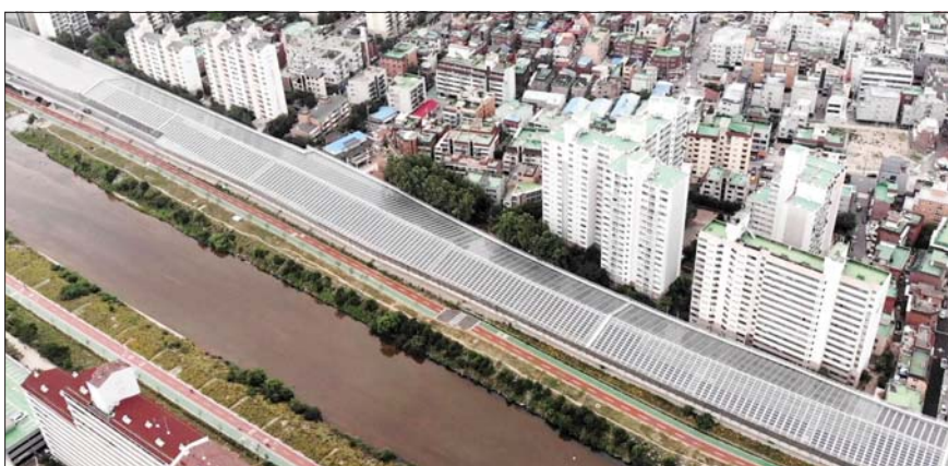
동부간선도로에 설치된 태양광 방음터널. /서울시
