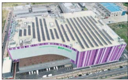
BGF리테일의 충청북도 진천군 소재 중앙물류센터 지붕의 태양광 발전소. /한화큐셀
