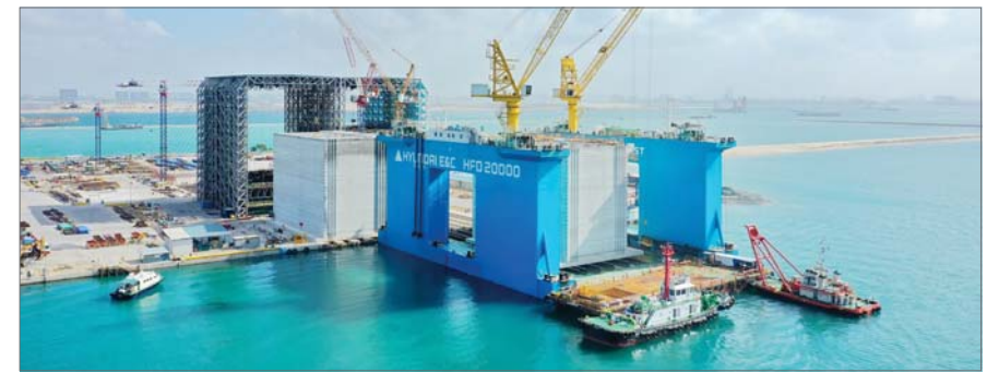
싱가포르 투아스핑거3 매립공사 현장. /현대건설
