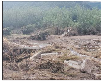
하천예방사업 페콘크리트 모습.
