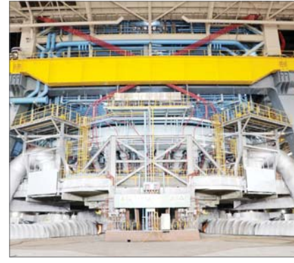
포스코 광양제철소 새단장 마친 3고로.
