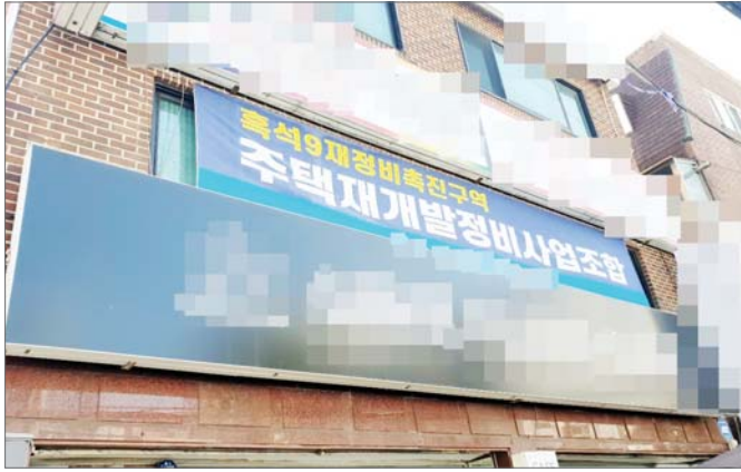
서울 동작구 흑석9구역 재개발 사업이 조합원 간 갈등으로 정상화에 차질을 빚고 있다. 흑석9구역 주택재개발 정비사업조합 임시 사무실 과 동네 전경
