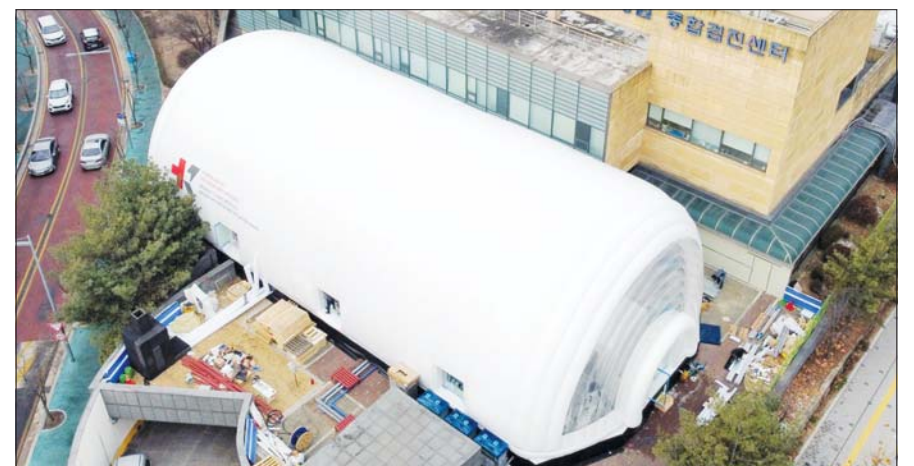
한국원자력의학원에 설치된 이동형 음압병동 외경.
