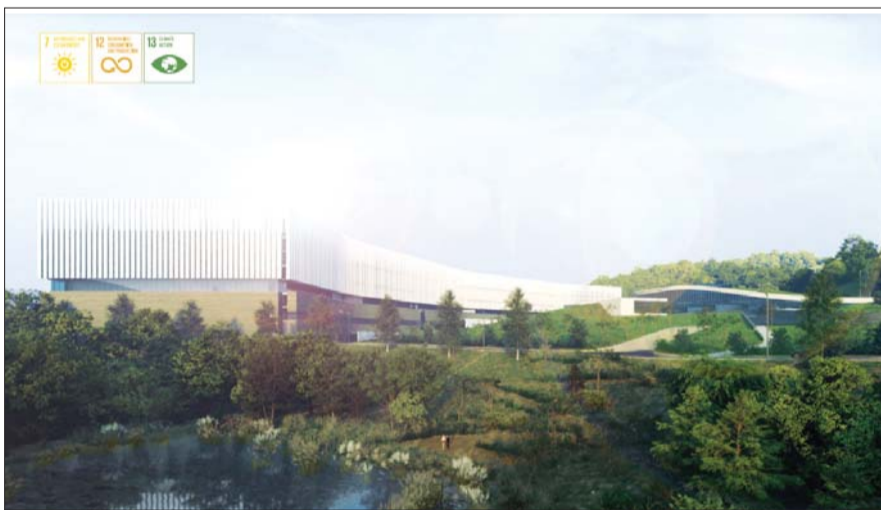
네이버 데이터센터 ‘각’ 전경. /네이버
