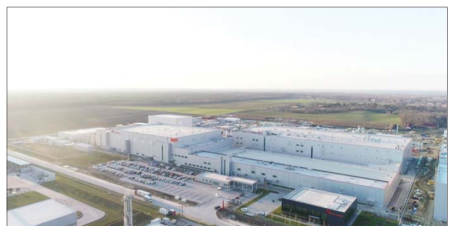
헝가리 코마롬에 위치한 SK이노베이션 유럽 제1 전기차 배터리 공장.
