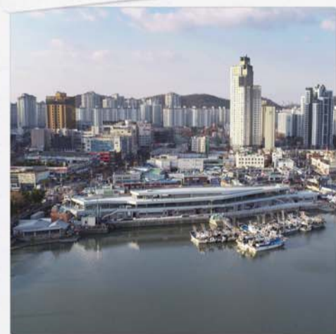
12월 그랜드 OPEN 소래포구 어시장 인천광역시 남동구 장도로 86-17 | 010-9138-7190
