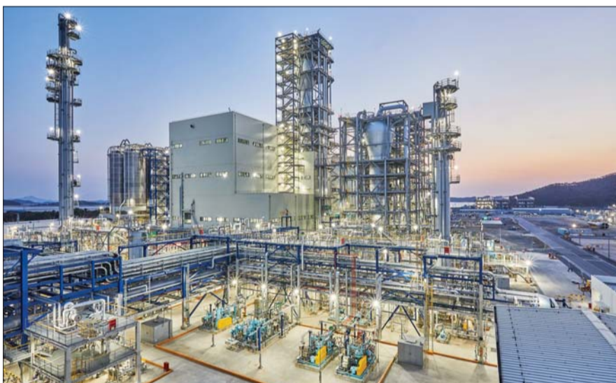
한화토탈 폴리프로필렌 공장.
