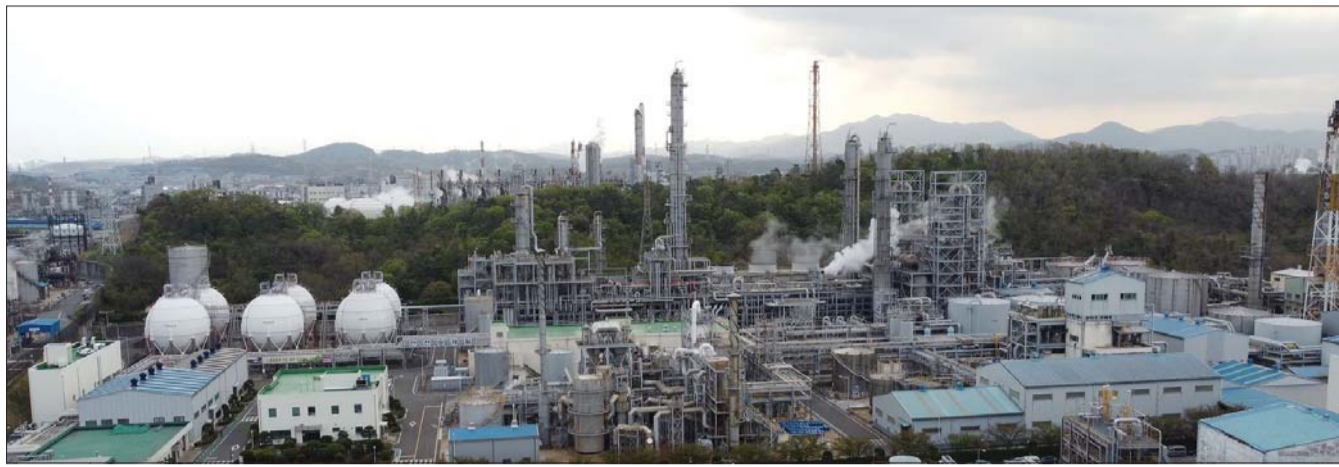
태광산업 석유화학 3공장.
