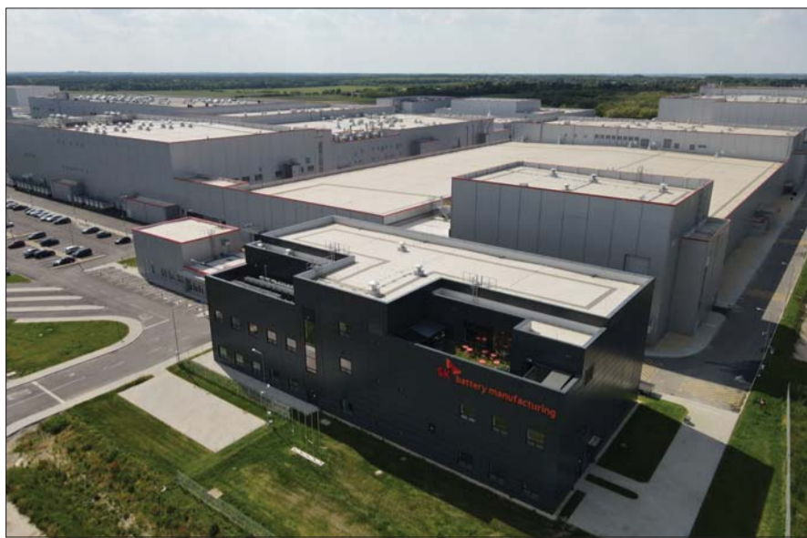
SK이노베이션 헝가리 제2공장.
