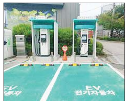
죽전휴게소에 설치된 350kW급 전기차 초고속 충전기. /환경부
