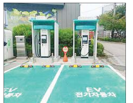
죽전휴게소에 설치된 350kW급 전기차 초고속 충전기. /환경부
