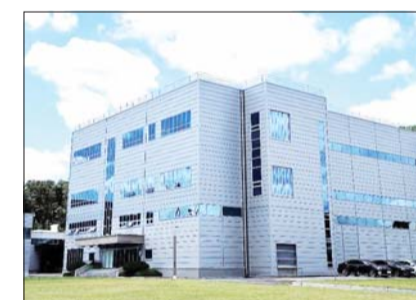
보령바이오파마 진천공장 전경
