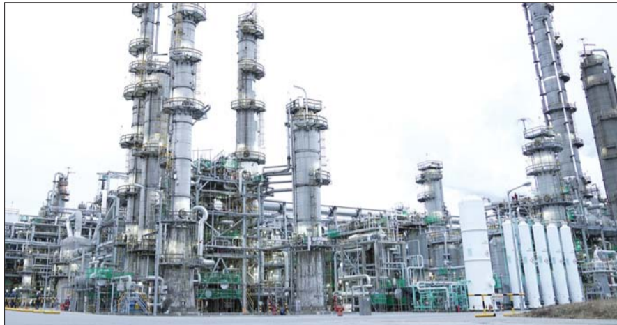
롯데케미칼은 대산공장 내 전기차 배터리용 전해액 유기용매인 EC와 DMC 생산시설 건설 등 고기능·배터리 소재분야 진출을 적극적으로 추진 중에 있다. 사진은 대산공장 전경 /롯데케미칼
